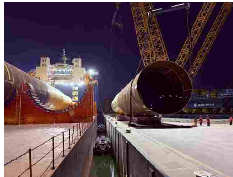
Foto: load-out van monopiles voor Empire Wind 1
